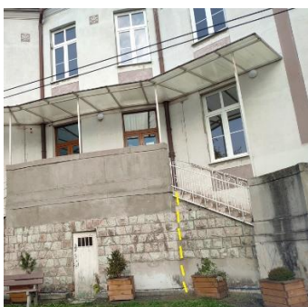
10. Vonkajšie schodisko, žltou naznačené pokračovanie odkvapovej rúry v sklade – interiér skladu na foto 11+12.
