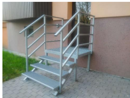
21. Pr. schodiska so stupňovými klinmi kotvenými zhora do bočných schodníc
